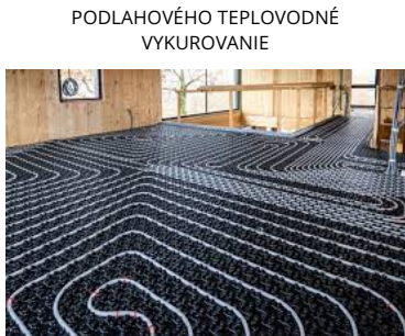
PODLAHOVÉHO TEPLOVODNÉ VYKUROVANIE
